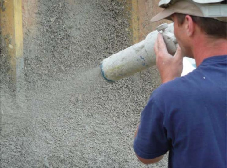
Projection mécanique par machine sur une banche.
