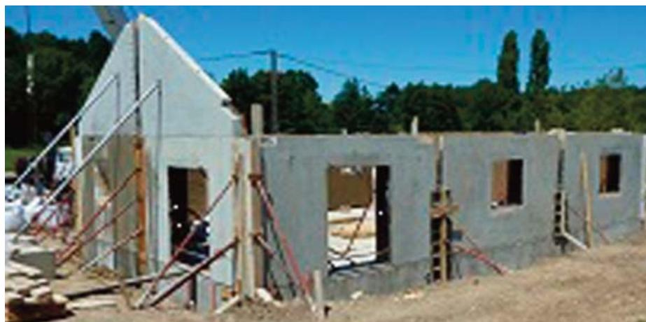
Assemblage de voiles béton de chanvre + béton léger.
